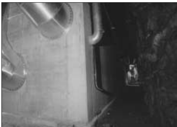
Grotte réservée au stockage, creusée dans la montagne The mountain storage vault
