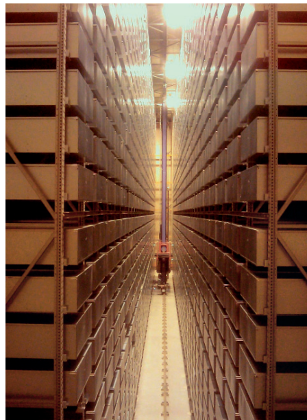
1. El interior del depósito automatizado (o siló) del Archivo General de la Administración de Euskadi, en Vitoria-Gasteiz, obra de Iñaki Aspiazua y LKS Ingeniería. Al fondo del pasillo se observa el robot transelevador.
